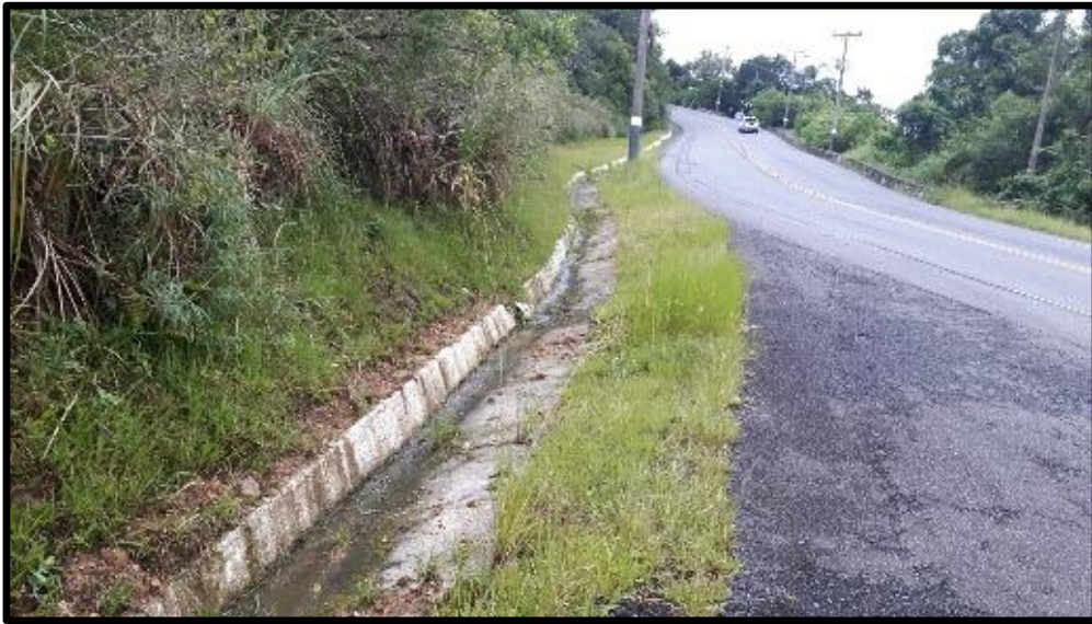
Figura 54 – Canaletas (drenagem pluvial)
