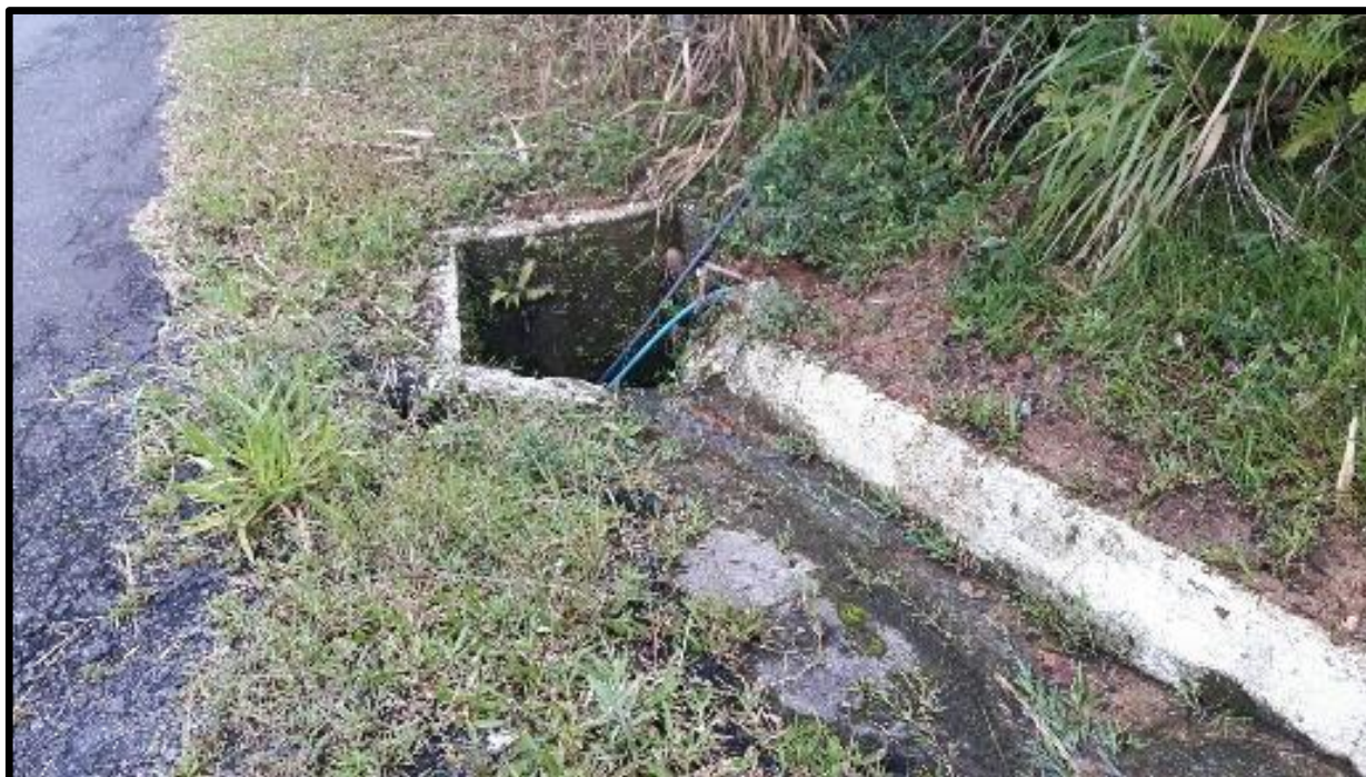
Figura 59– Boca de lobo (drenagem pluvial)
