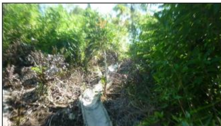
Figura 13. Canaleta de drenagem oriunda de terrenos vizinhos situados no topo do morro. Próximo ao lote 5.
