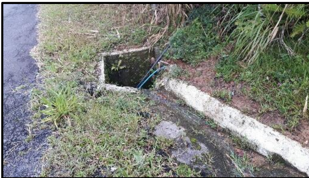
Figura 53– Boca de lobo (drenagem pluvial)
