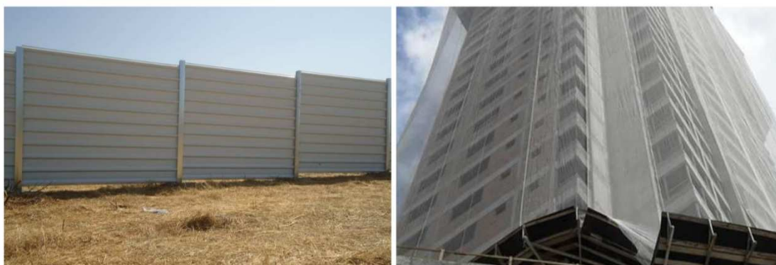
Figura 138. Exemplo de tapume para sinalização de obras.
